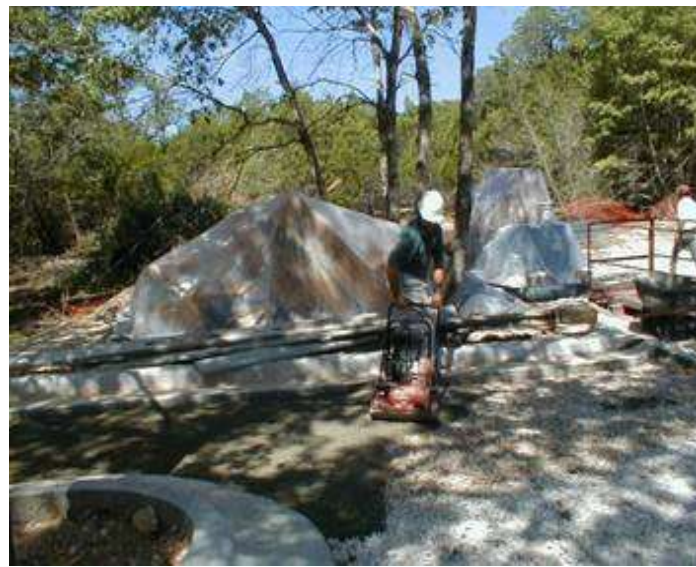
Uso de vibro-compactadora. OBRA: "Sundown", edificio de oficinas en Austin, TX., USA
