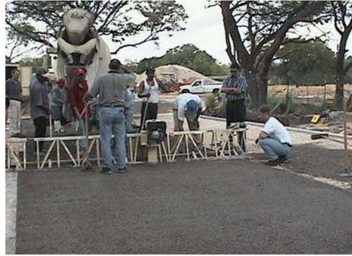
Tendido con regla vibro-compactadora. OBRA: Estacionamiento centro comercial. Austin, TX., USA
