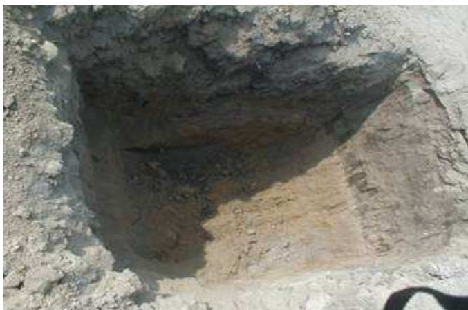
Pozo indio OBRA: Walmart Zumpango
