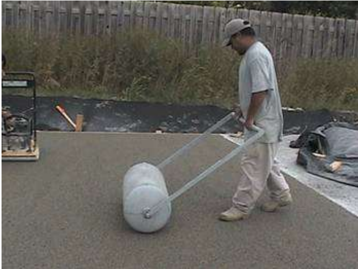
Uso de rodillo de mano. OBRA: Centro de Capacitación de ECOCRETO USA
