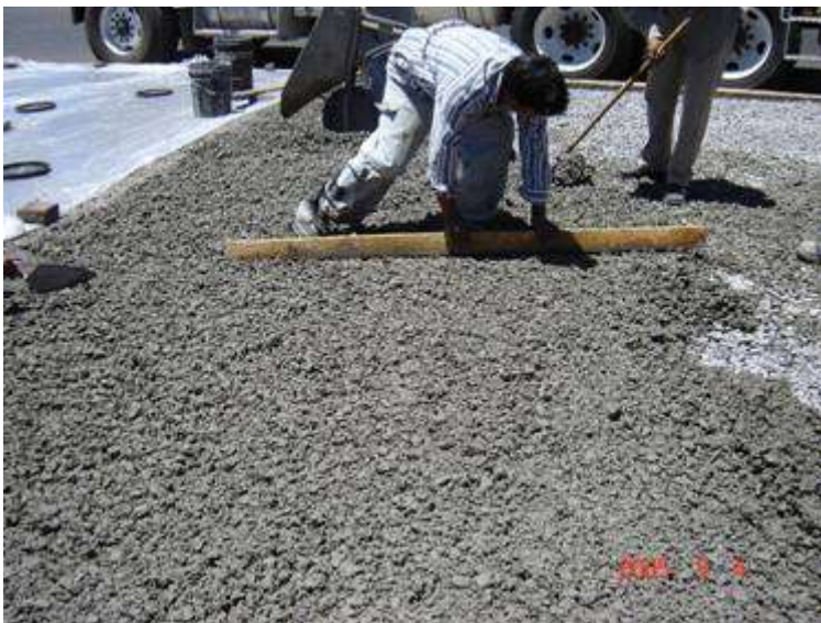
Nivelación del piso con regla. OBRA: Zamora, Michoacán
