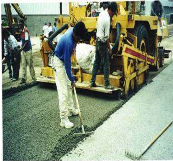
Tendido del pavimento con “finisher” para asfalto. Centro Exhibimex, San Pedro de los Pinos, Méx., D. F.
