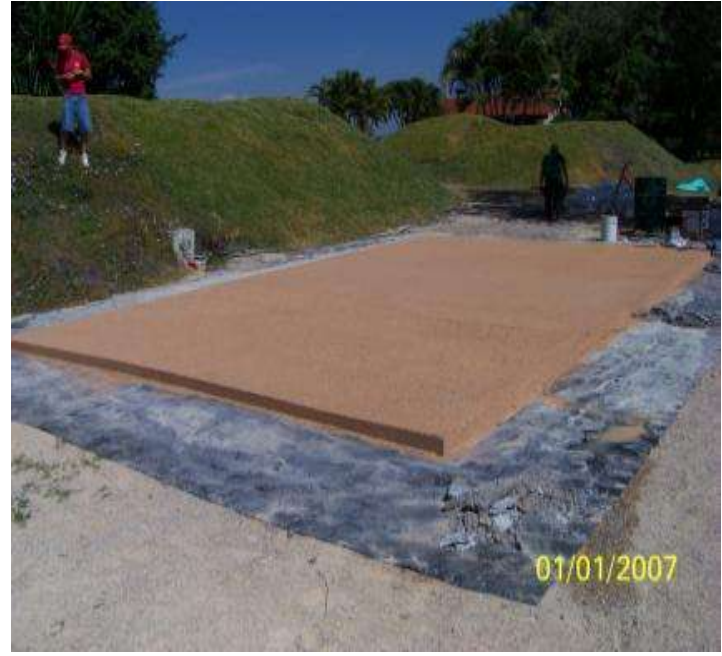
Recuperación de agua con plástico en la base.
