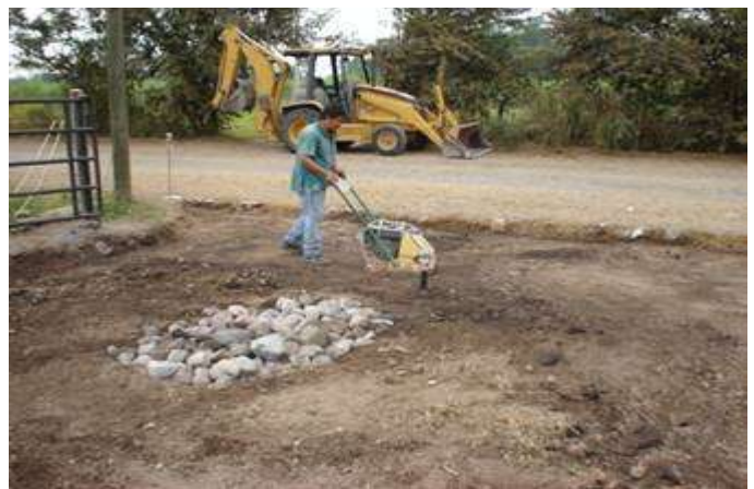
Pozo indio relleno con boleos. OBRA: Rancho en la ciudad de Colima, Colima
