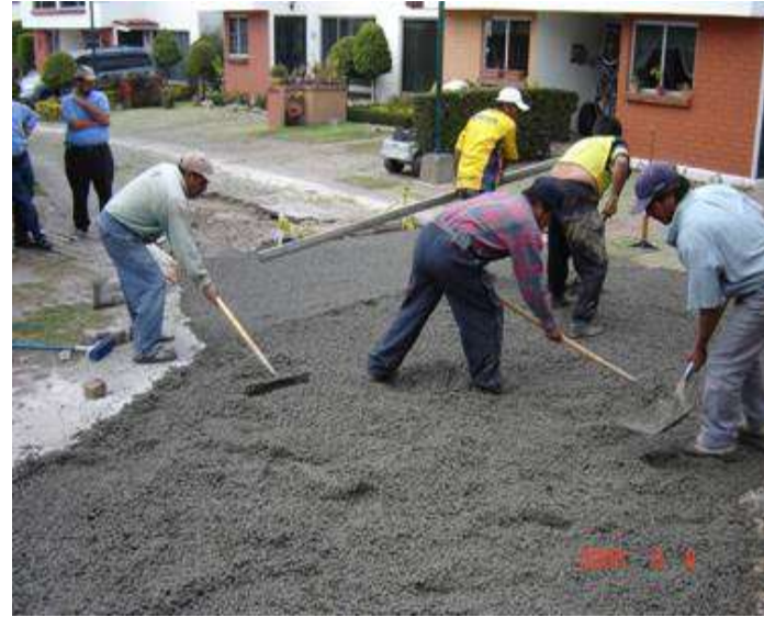
Acomodo de la mezcla con rastrillos y palas. OBRA: Fuentes de Satélite, Naucalpan, México.
